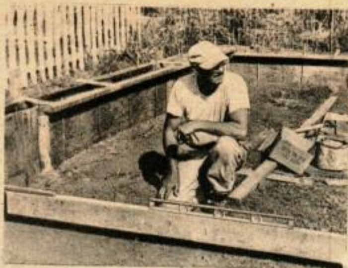
Mettez les coffrages de niveau, à la porte du garage, avec une planche allant d'une cloison à l'autre.
