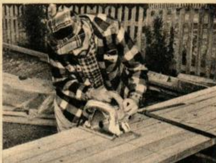
UNE SCIE CIRCULAIRE portable coupe rapidement les poteaux dans les bois de 50 \times 100 posés les uns à côté des autres, et marqués avec l'équerre (ci-dessus).
