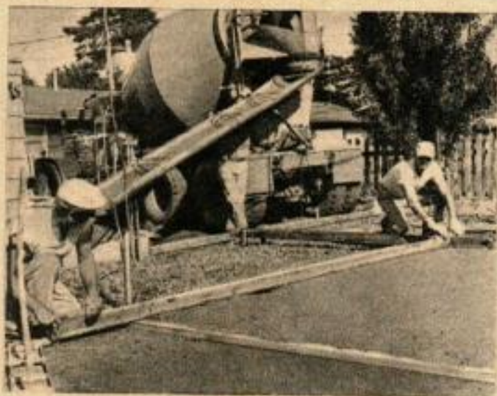
Les tuyaux qui se dressent sont gênants ; il faut aplanir jusque-là, puis remplir le reste.
