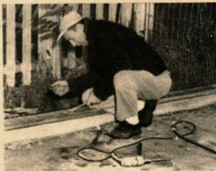
Ancrer la semelle aux fondations en perçant des trous en face des boulons, en posant la semelle, et en serrant les écrous avec une clef.
