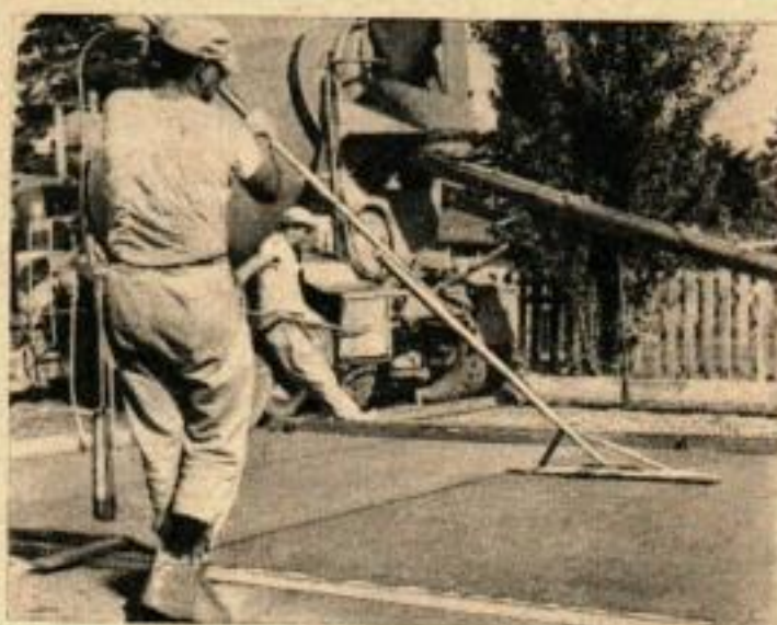
Couler, niveler, damer et aplanir la surface entre le guide et le bord du patio.
