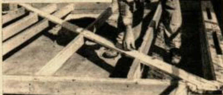
Montage du mur sur le sol ; ici apparaît la décharge clouée dans les fentes des poteaux ; mettre deux clous par poteau.
