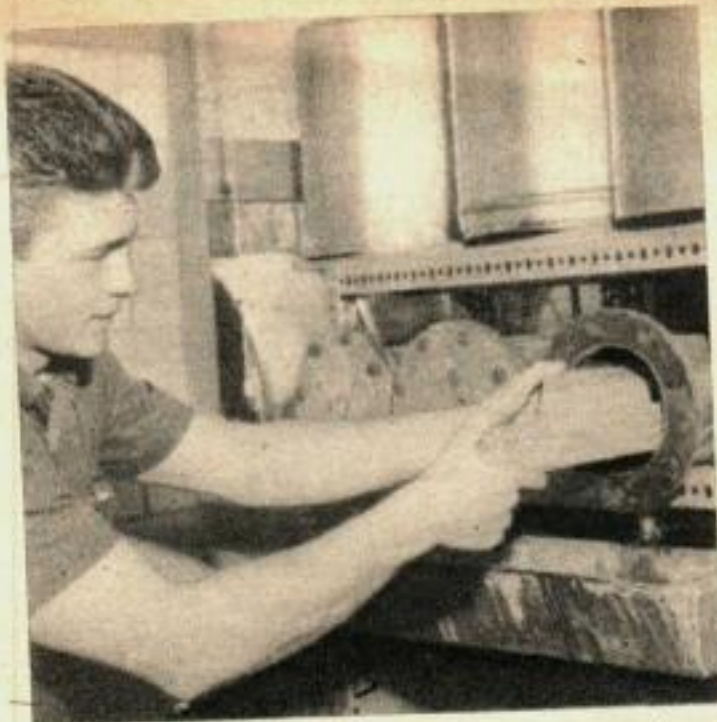
Du bois ordinaire est placé dans une chambre à vide. Ayant perdu l'air qu'il contenait, il absorbe la matière plastique introduite dans la chambre à l'état liquide. Cette dernière est ensuite solidifiée par un bombardement de rayons gamma.
