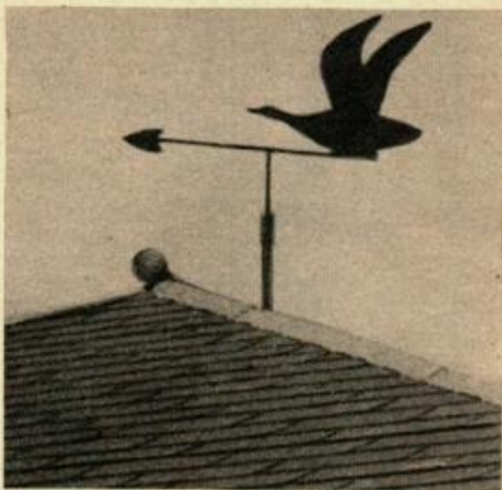
Sur le toit, une jolie girouette vire au vent en pivotant sans difficulté sur des roulements à billes montés dans une gaine hermétique.
