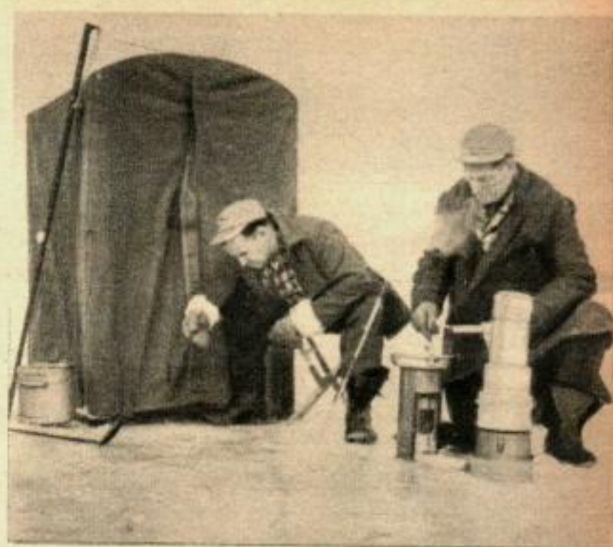
Le ciseau de glace est appuyé contre un abri de toile près du seau d'appât et d'une petite pelle qui sert à dégager le trou. Pendant qu'un pêcheur s'occupe de la ligne, l'autre prépare le déjeuner chaud.
