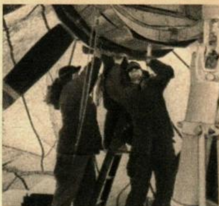
Des mécaniciens travaillant les mains nues font de petits travaux d'entretien sur un moteur de « C-47 ». Sans la tente chauffée constituée par un parachute, les mains resteraient collées sur les parties métalliques extrêmement froides.
