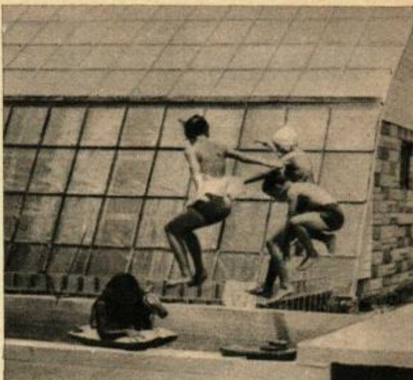
La piscine en plein air de la première maison solaire de Thomason était chauffée par l'énergie solaire accumulée dans le caisson formant masse thermique. Les enfants s'y baignaient encore quand la première chute de neige arriva.
