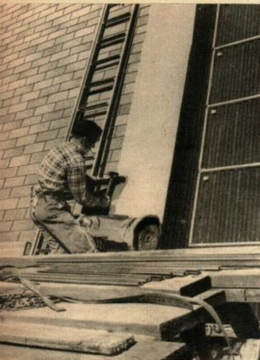
L'installation du piège à chaleur sur le toit de la dernière maison. Le toit lui-même est isolé. Par-dessus, une couche de fibre de verre, l'aluminium ondulé, et, par-dessus le tout, des vitres.
