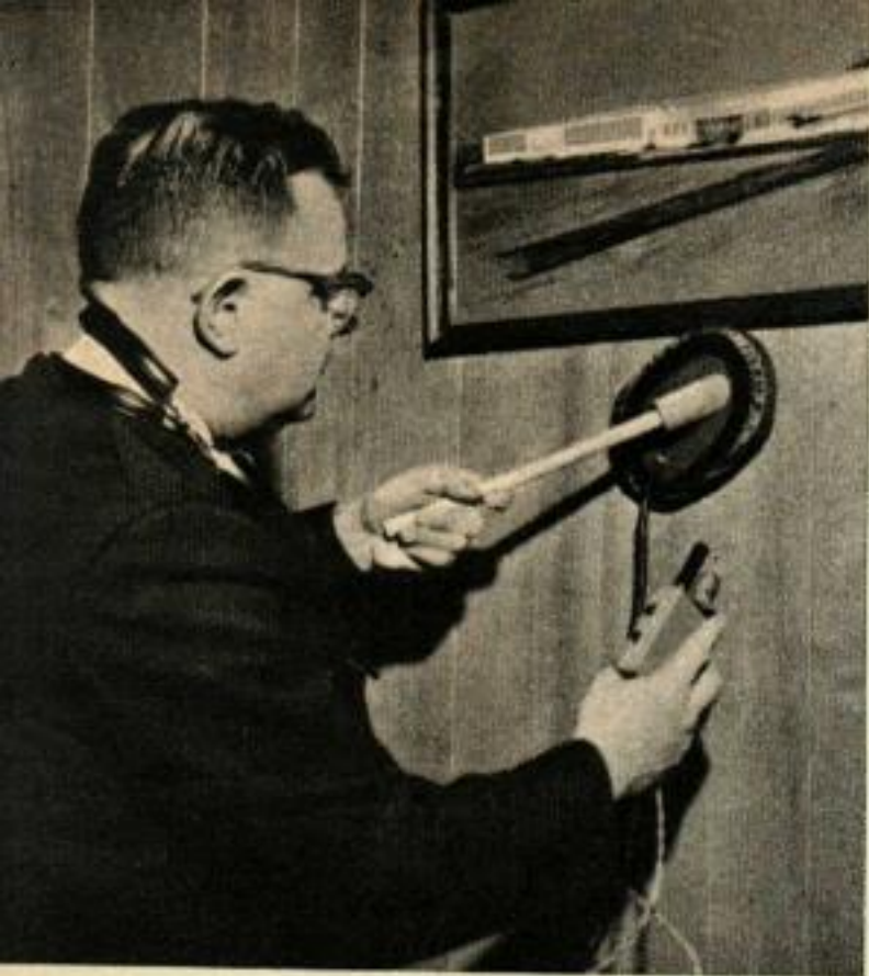
Pour repérer le micro qui aurait pu être camouflé dans un mur, le spécialiste anti-indiscret peut se servir d'un petit détecteur de mines. Un appareil d'écoute caché ferait bouger l'aiguille du cadran.
