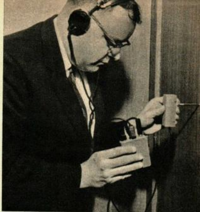
Une pointe enfoncée dans le mur avec un micro de contact appliqué dessus est si sensible qu'elle peut faire entendre des bruits intempestifs venant des autres salles voisines et masquer ainsi la conversation.
