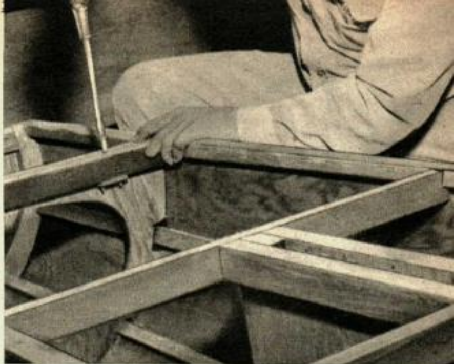
Avant de ponter les coques, passer les boulons d'assemblage dans les trous des tasseaux pour s'assurer que les garnitures d'acier filetées de la cloison sont parfaitement alignées.
