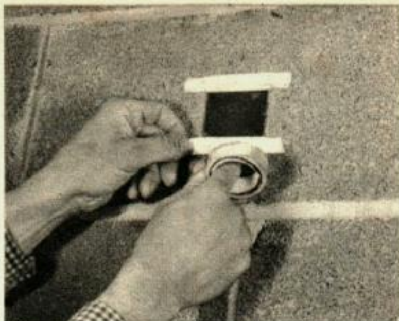
UN MIROIR DE POCHE ou un morceau de fer-blanc bien lisse peuvent servir de détecteur pour déterminer si l'humidité du sous-sol est causée par la condensation ou par l'infiltration. Placer l'objet contre le mur avec de la bande adhésive toute une nuit ; si le miroir est couvert de buée, la condensation est en cause.
