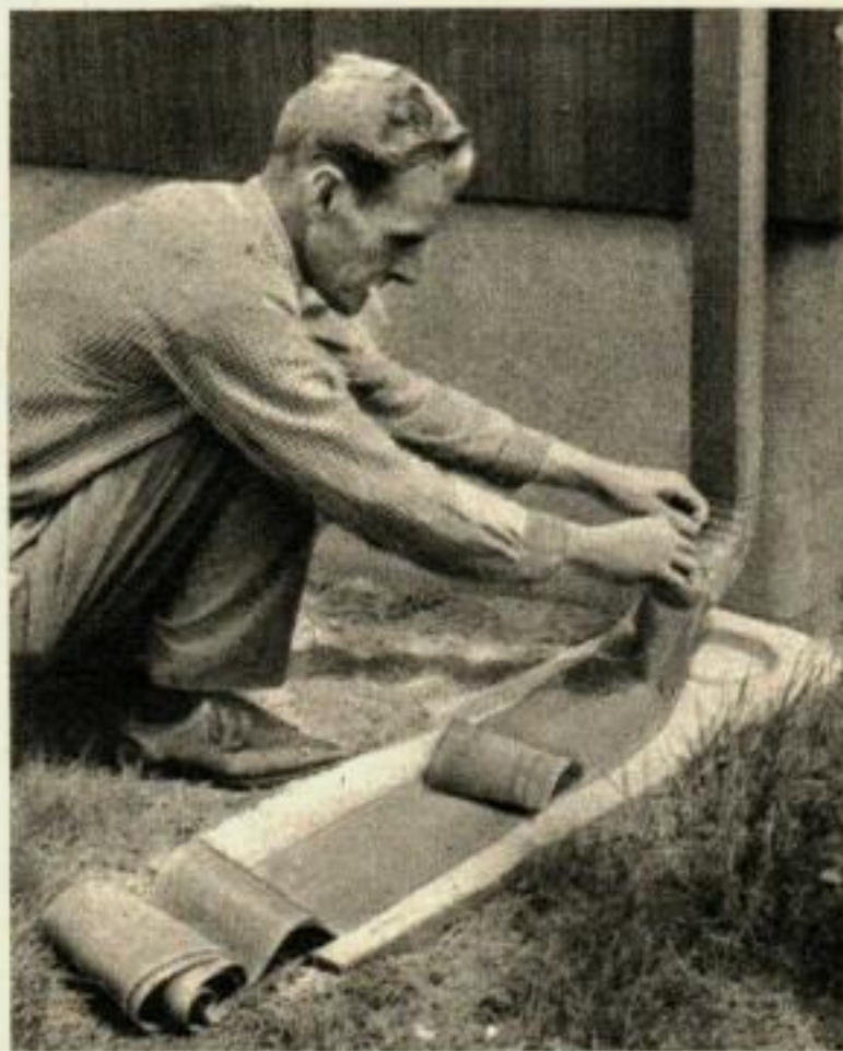
LA DESCENTE DE GOUTTIERE, si elle n'aboutit pas à quelque distance de la fondation peut causer des infiltrations à travers les murs du sous-sol. Un prolongement en matière plastique qu'on voit ci-dessous, canalise l'eau en l'éloignant de la maison et en la distribuant sur le gazon par des trous d'arrosage.
