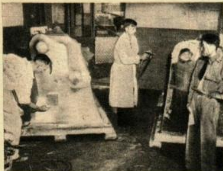
Les employés du gouvernement projettent une pellicule isolante sur les machines pour qu'on puisse les expédier au centre de décontamination. Une méthode usuelle pour traiter certains équipements.
