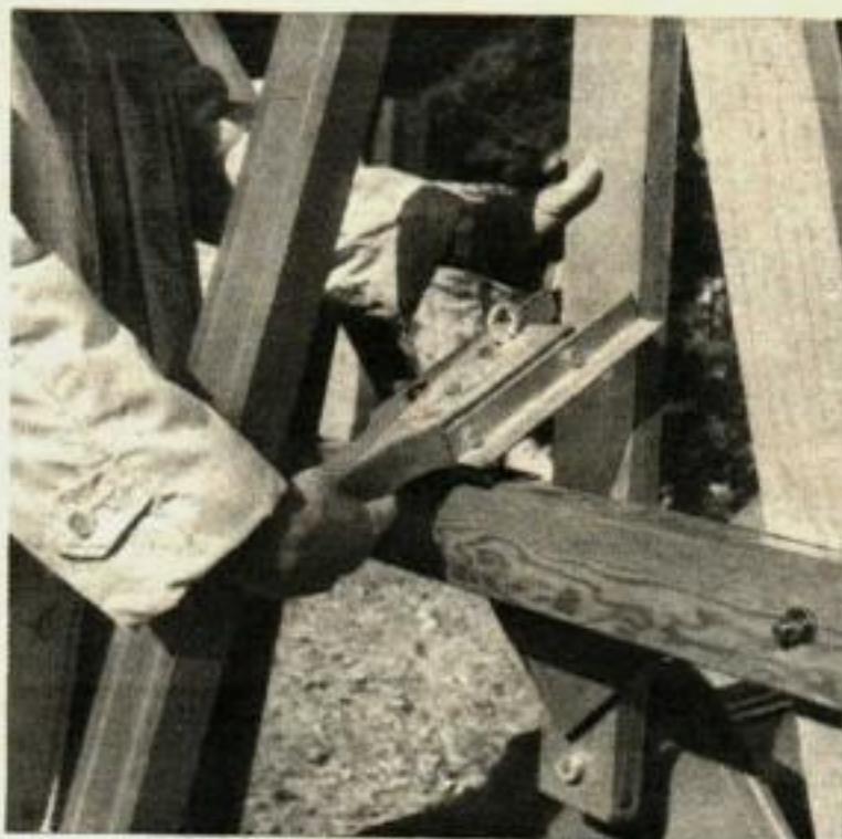
Des loquets pivotants sont prévus pour que les enfants ne puissent utiliser la roue sans être surveillés par des adultes.
