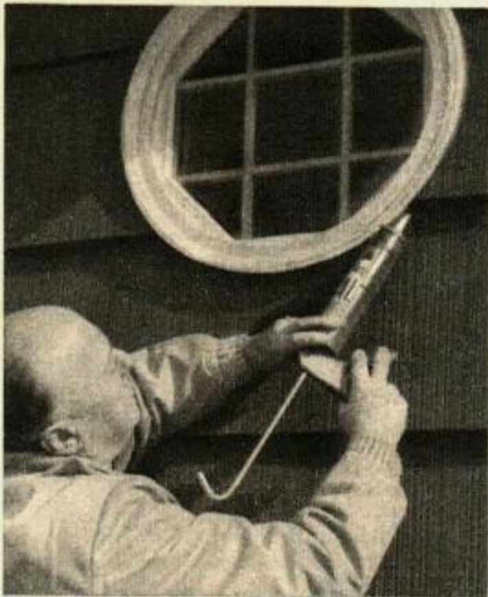
L'application de mastic avant de refaire la peinture est la meilleure assurance que l'eau ne pénétrera pas sous la peinture pour la soulever.
