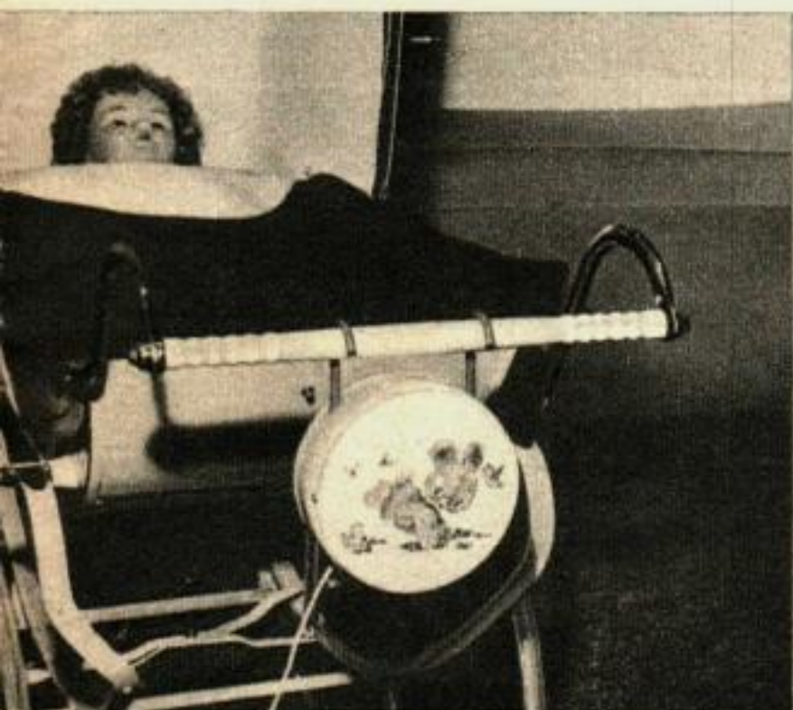
CETTE BERCEUSE AUTOMATIQUE permet d'endormir le bébé tout en faisant le ménage. L'appareil peut s'adapter sur la poignée de n'importe quel landau et l'alimentation électrique se branche sur une prise de ménage. Il donne un léger balancement silencieux, propice au sommeil.
