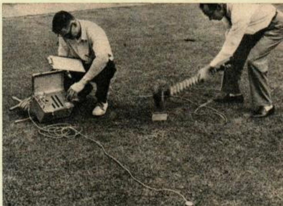
Les ondes de choc parcourant le sous-sol subissent des variations du fait de la nature différente des roches. On peut en mesurer la surface à l'aide d'un géophone qui enregistre les ondes de choc provoquées par des coups de masse.
