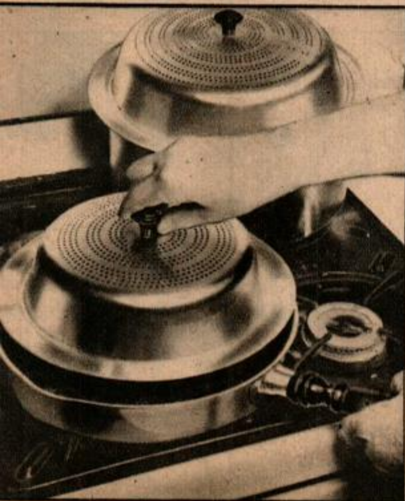
2. Ci-dessus, élément chauffant amovible placé dans la partie supérieure d'un fourneau électrique ménager. Des éléments interchangeables peuvent être utilisés pour l'ébullition ou la grillade. Le four est suffisant pour une dinde de 10 kgs et le fourneau est utilisable dans un appartement même petit ou dans une remorque ou une roulotte.
