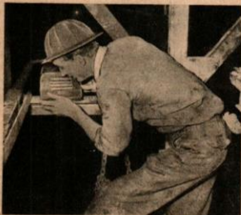
Le haut-parleur du mécanicien possède un conducteur de grande longueur permettant d'avoir l'appareil constamment à portée de la main pour recevoir les instructions du foreur. Ci-dessous, le haut-parleur installé dans le « sous-sol » évite de nombreux accidents.
