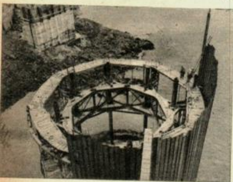
Des caissons classiques ont servi aux opérations sous l'eau. On a exécuté les fondations des cylindres de béton sous le fleuve.
