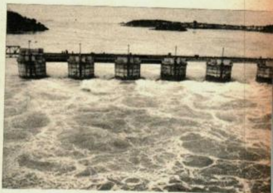
L'originalité de la méthode réside dans des cylindres de béton préfabriqués plantés comme des pieux ; en remplissant l'intervalle entre les cylindres, on achevait le batardeau.
