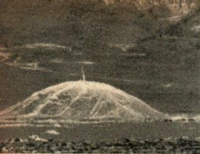
Une grosse boursofflure de 250 m de large, 100 de haut, voilà ce que donnent les 100 kilotonnes de la bombe Sedan, enfoncée profond. Quand la bulle crève...
