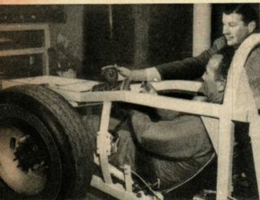
En cours de construction, Arfons est assis dans le cockpit du Wingfoot pour vérifier les dimensions, ainsi que l'emplacement des instruments. Aucun détail ne fut négligé.
