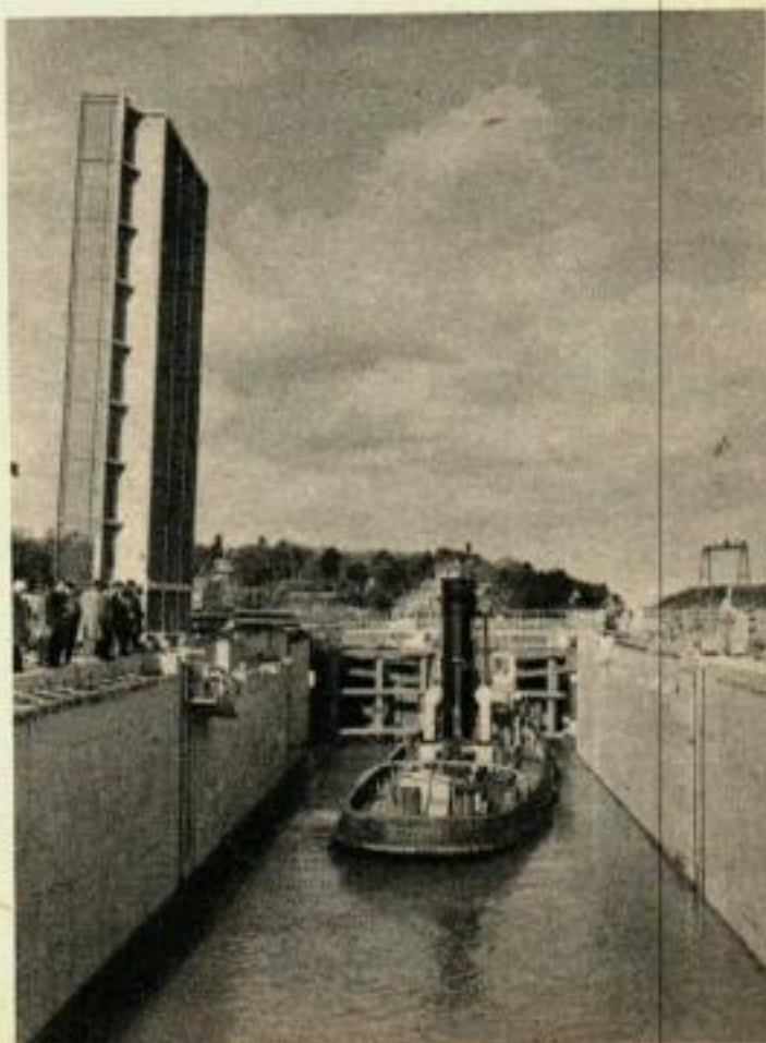
L'écluse de navigation de la rive gauche mesurant 65 m de long et 13 m de large fonctionne depuis le 19 novembre 1962.
