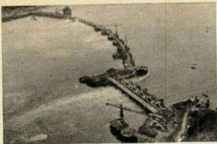
Vue d'ensemble du chantier dans l'estuaire de la Rance. Au premier plan, l'écluse déjà achevée. Les batardeaux dans le lit de la rivière sont presque terminés. Après leur achèvement le deuxième système de batardeaux situé en amont (à gauche) a pu être érigé dans des eaux calmes permettant ainsi d'obtenir un chantier sec pour la construction de la digue de l'usine.
