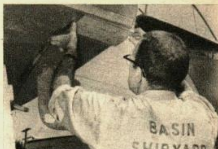
La garniture métallique recouvrant le bord d'attaque des cales peut être omise si on compte recouvrir de fibre de verre.
