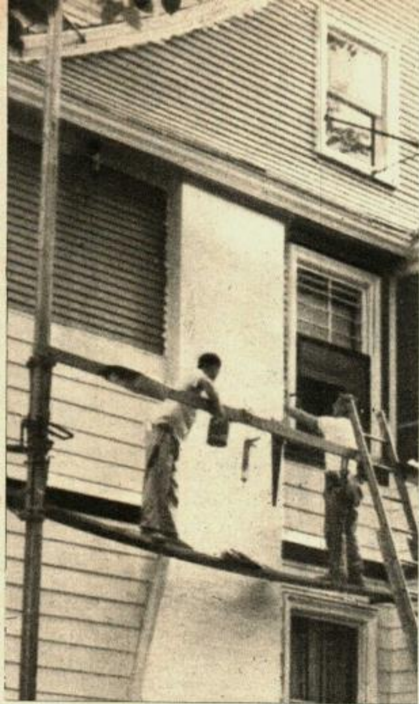
DES LATTES PORTANT des lignes de repère imprimées et renforcées de fibre de verre. Les lignes permettent de couper et de clouer avec précision.
