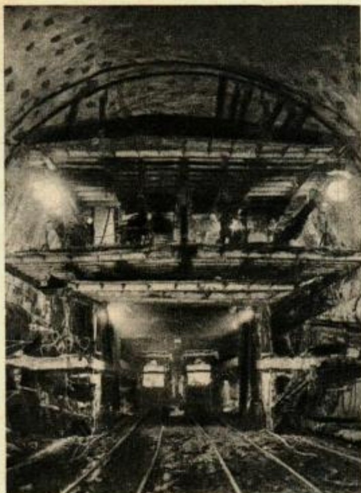
Le machine - perceuse à forets multiples « Jumbo » en extrémité de galerie, vue de face. Les forets sont placés par trois étages. L'étage inférieur est pourvu d'une ouverture permettant le passage de pelles électriques. (Photo G. Fairraz - Chamonix.)
