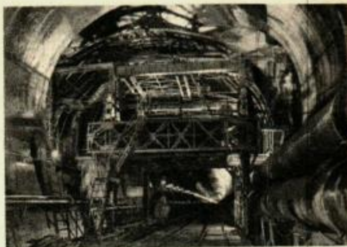
La coquille métallique mobile permettant de bétonner les parois du tunnel. Photo G. Fairraz - Chamonix.
