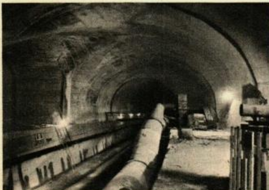
Une section déjà bétonnée près d'une voie de garage. Une telle possibilité de dégagement et de parcage est fournie tous les 300 m afin d'assurer un écoulement ininterrompu du flot de voitures en cas d'une panne. La hauteur du sol de la voie de garage (à gauche) indique en même temps à quelle hauteur se trouvera la chaussée dans le tunnel. Le gros conduit sert à l'aération du chantier en extrémité de la galerie et avant tout à aspirer la poussière dégagée par les explosions. A droite de la section transversale du tunnel on reconnaît une sorte de niche prévue tous les 50 mètres (en dehors des voies de garages). Photo G. Fairraz - Chamonix.
