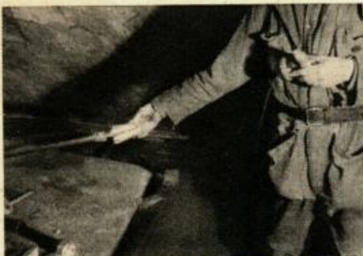
Le goujon qui s'écarte à l'extrémité avant du boulon d'ancrage. Après l'introduction dans le trou percé à cet effet la tige d'acier est solidement ancrée dans la roche du fait que les pièces fixées à l'avant s'écartent.
