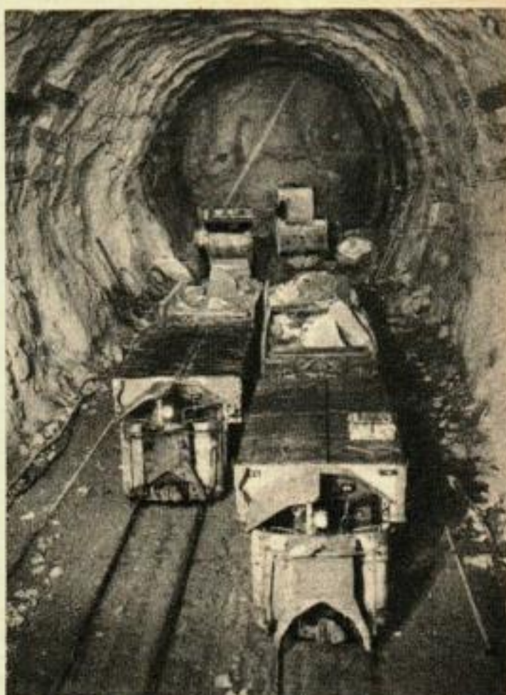
Les pelles électriques — « Conway » — déblayant de la roche abattue. Au premier plan, les locomotives électriques avec les berlines déjà remplies. (Photo G. Fairraz - Chamonix.)
