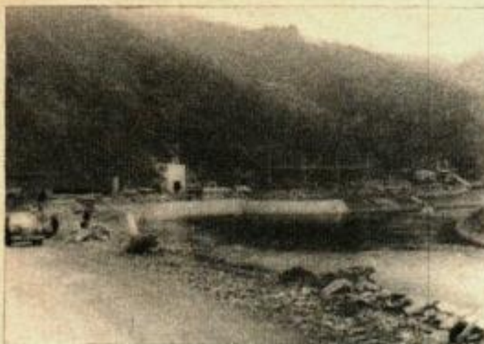
LA BOUCLE DE L'OUR avec l'entrée dans la galerie des transformateurs et la caverne située à l'intérieur de la montagne. Ce sont les seules installations visibles de la centrale si l'on ne tient pas compte du barrage modeste en amont de Vianden et de l'installation du bassin supérieur en harmonie parfaite avec la nature.
