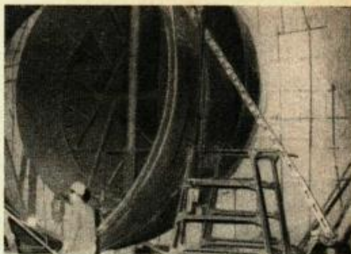
LE BLINDAGE DU Puits dans la roche du mont Saint-Nicolas destiné au conduit forcé de la deuxième tranche de construction.
