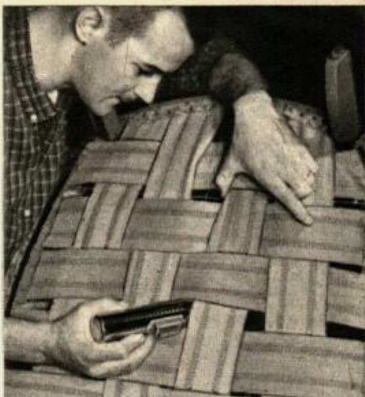
Eclairer les ressorts avec une lampe torche pour vérifier leur état. Si tout est en bon état, on peut commencer à monter les sangles d'acier.
