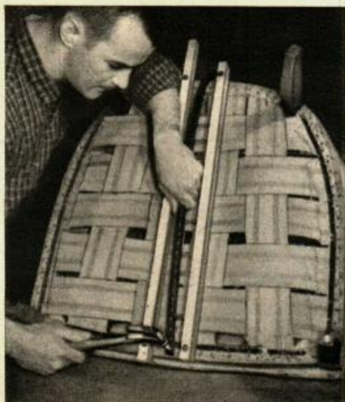
Bander les rangées de ressorts avec des barres de bois vissées sur le cadre. Laisser un espace entre les barres pour monter la sangle.
