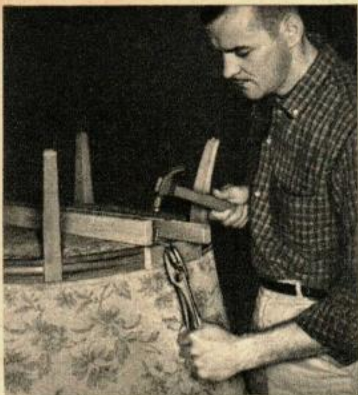
Une pince ou un tendeur de sangle tend la sangle à l'arrière du cadre, l'autre bout étant cloué au bord opposé du cadre.
