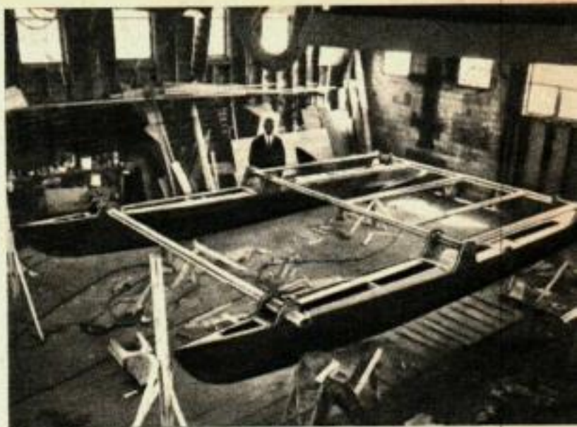
Réunies par trois traverses en tube d'aluminium, les nacelles jumelées du « Beverly » de 7,6 m sont écartées pour lui donner la largeur énorme de 4 m.
