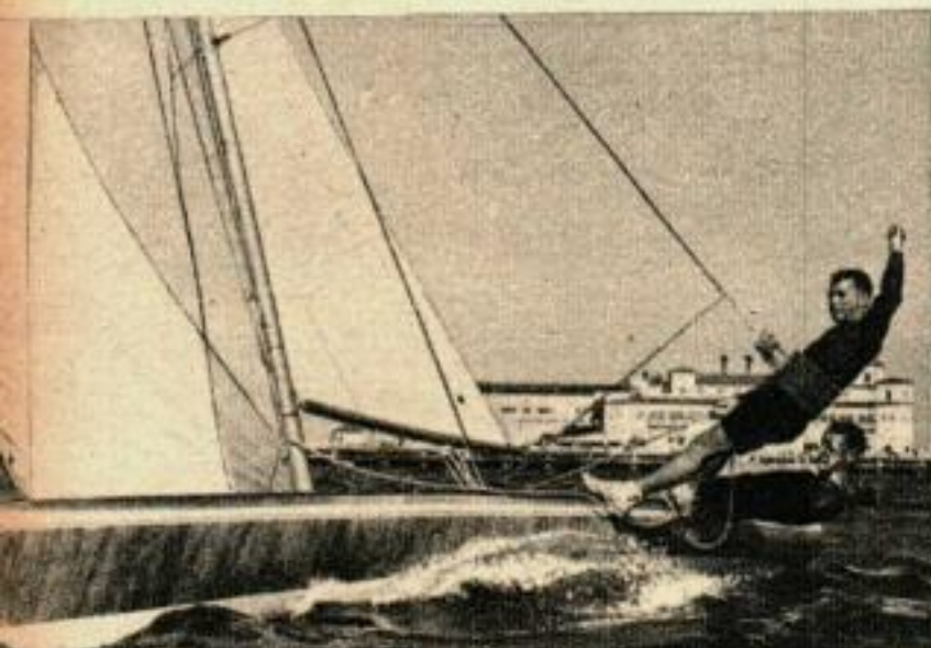
LES SANGLES D'EQUILIBRE fixées en avant et en arrière des deux côtés du bateau, permettent aux passagers de se pencher du côté du vent sans risquer de boire la tasse.
