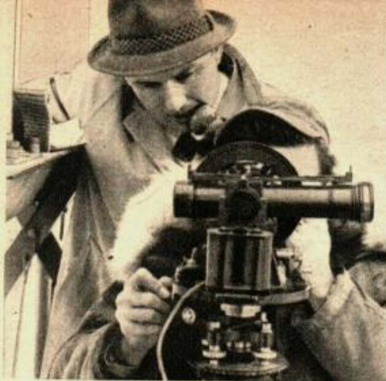
Le théodolite du contrôleur est réglé sur un angle prédéterminé et le technicien au microphone renseigne le pilote sur la route à suivre pour que l'avion reste dans le réticule.
