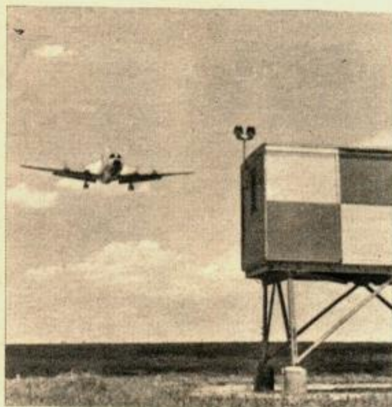
Atterrissage au-dessus d'une installation I.L.S. (à droite) par un jour clair. Lorsque la visibilité est nulle, le pilote ne peut compter que sur les signaux I.L.S. qui ont, par conséquent, besoin d'un contrôle constant.
