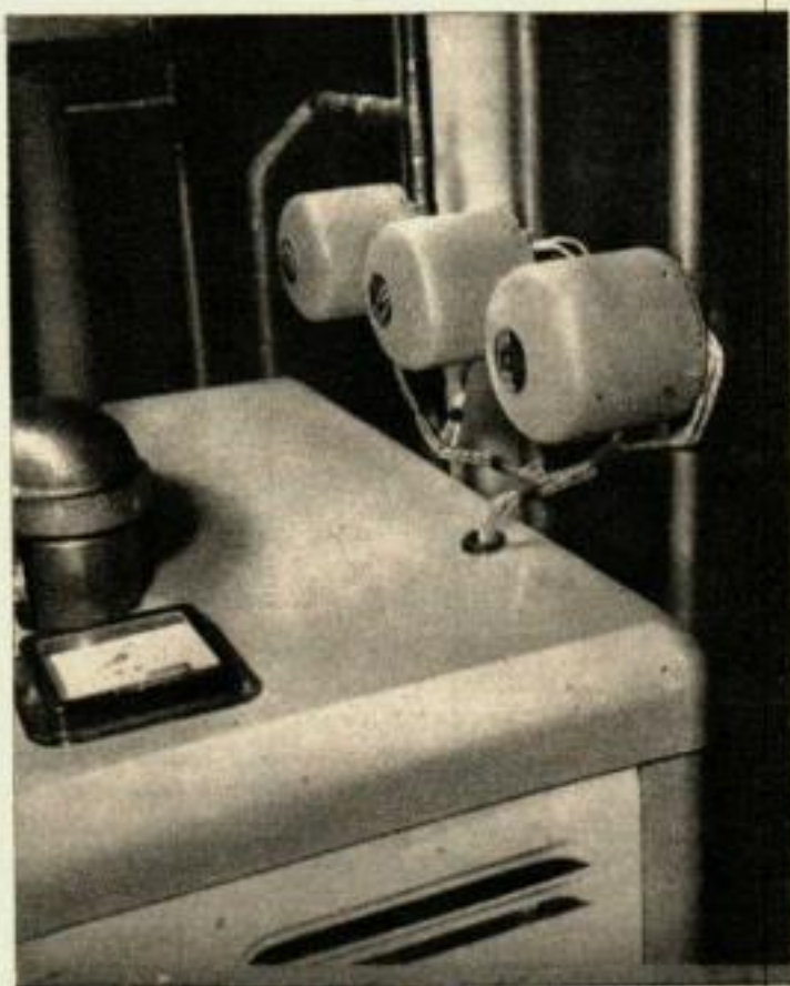
Dans les nouvelles habitations où le système de chauffage a été mis en zones au moment même de l'installation, les valves de zone sont généralement groupées près de la chaudière pour simplifier le câblage et la tuyauterie.
