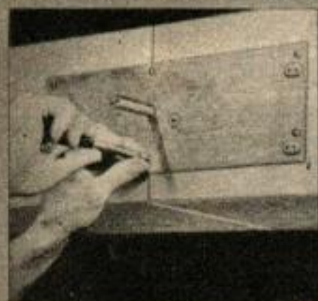
9. — Enfiler la plaque de montage sur l'axe et la visser sur la paroi du conduit.
