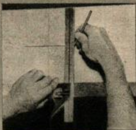
1. — Repérer l'axe du conduit où le régulateur de zone doit être monté.
