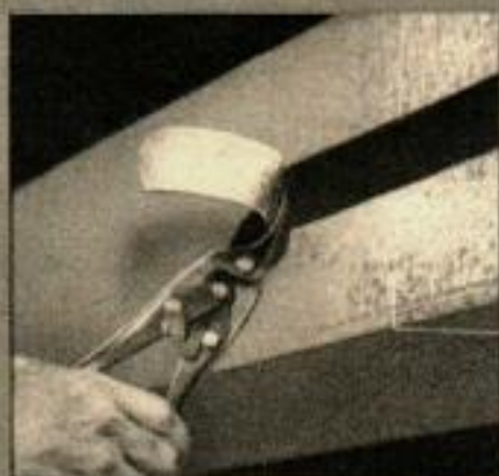
6. — Découper une fente sur la paroi du conduit pour pouvoir y introduire le volet du régulateur.
