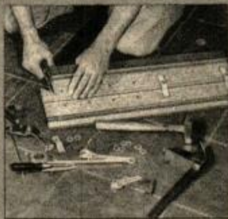
7. — Couper le volet à la largeur du conduit en ménageant un espace de 3 mm de chaque côté.
