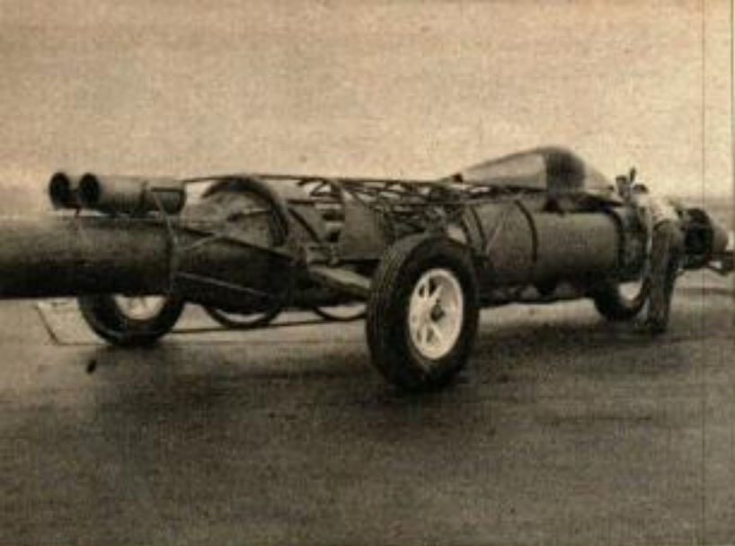
Le moteur J-47 monté sur un châssis d'essais du « Spirit of America ». Sa poussée statique est de 2 355,6 kg, elle peut être augmentée de 2 672,7 kg grâce à une injection d'eau et être portée à 3 442,8 kg avec un post-brûleur.
