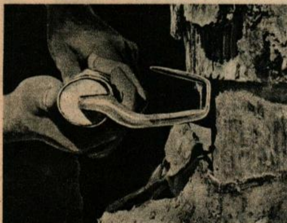
Nouveau procédé d'entaille utilisant un outil spécialement conçu par Keith Dorman à la forêt d'essai d'Olustee dans le Comté de Baker (État de Floride). Ci-dessous, la résine coule du pin dans un récipient de verre qui ressemble à un pot de fleurs.
