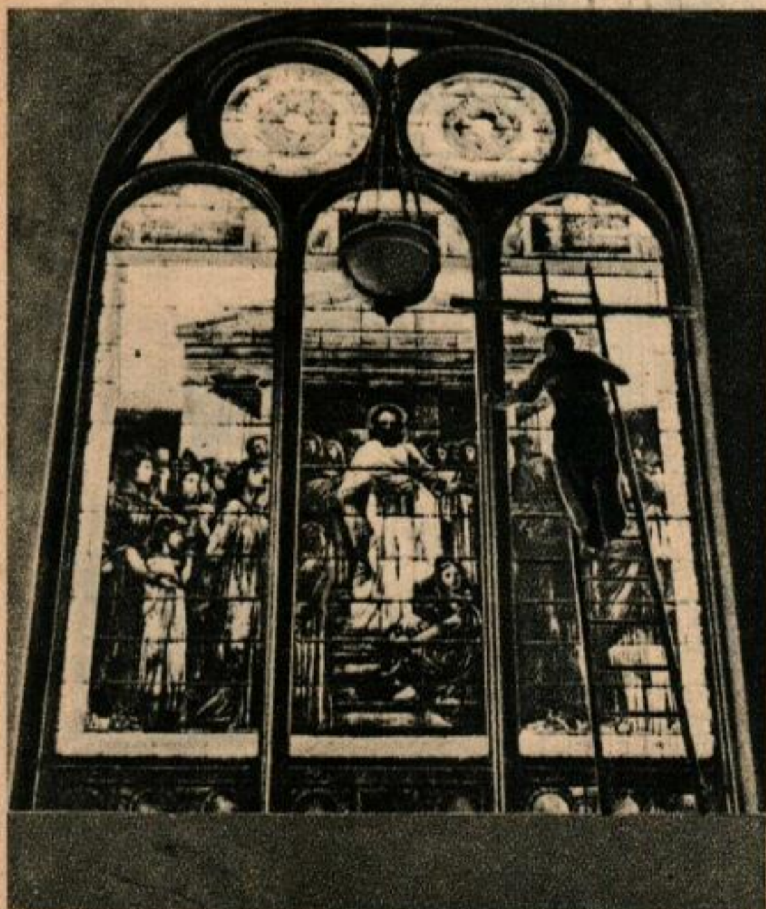
Les filets de plomb sont soudés pour assurer la solidité de l'ensemble. Ci-dessous, l'artiste nettoie un vitrail vieux de 50 ans et estimé 10.000 dollars avant d'en repeindre certains détails.
