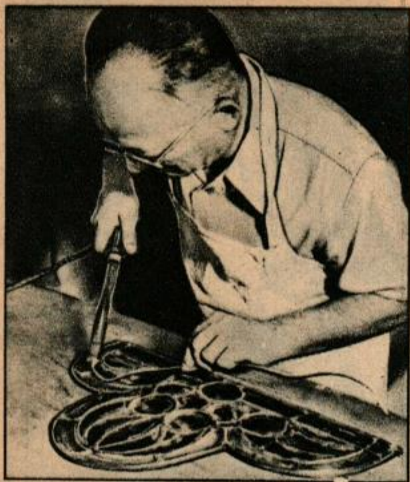
Les filets de plomb sont soudés pour assurer la solidité de l'ensemble. Ci-dessous, l'artiste nettoie un vitrail vieux de 50 ans et estimé 10.000 dollars avant d'en repeindre certains détails.
