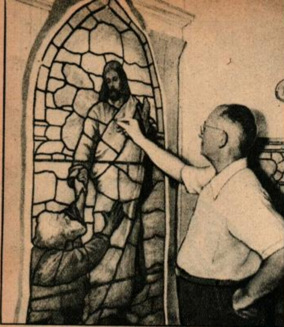
Le dessin au fusain est partagé en sections qui serviront de patron pour le découpage des verres (ci-dessous).
