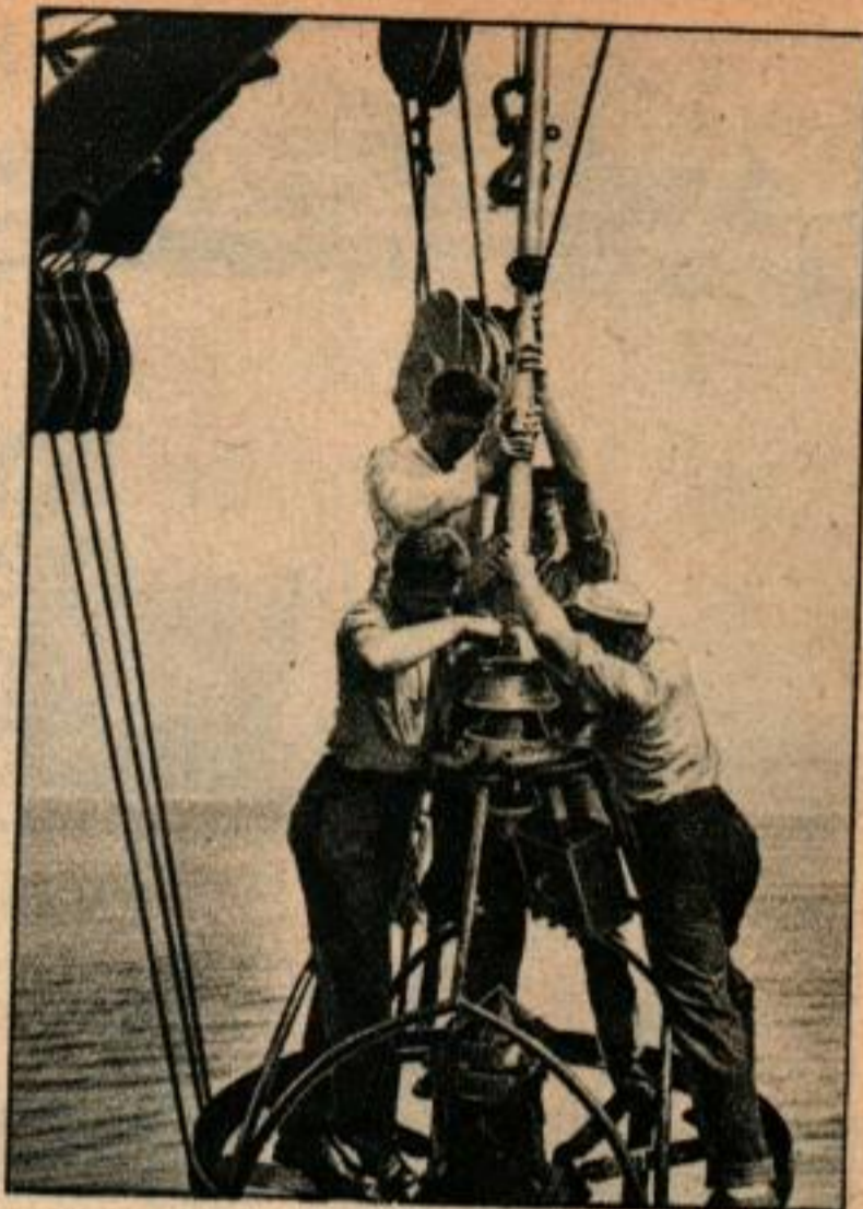
Installation d'une antenne (ci-dessus) et des batteries électriques (ci-dessous) sur une bouée-radio qui aide à la navigation en temps de brume.
