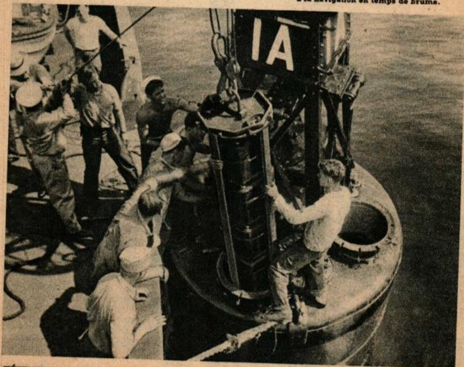
Installation d'une antenne (ci-dessus) et des batteries électriques (ci-dessous) sur une bouée-radio qui aide à la navigation en temps de brume.
