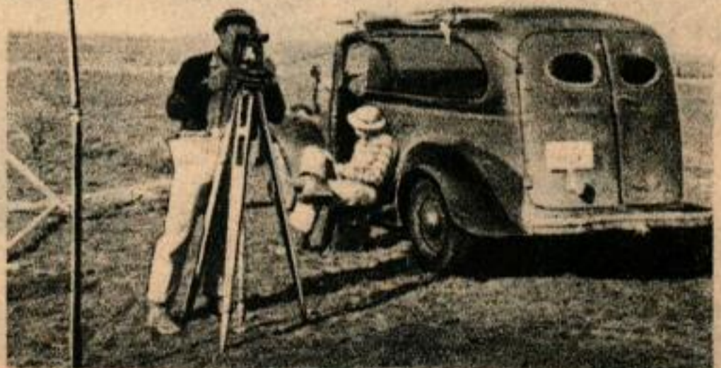
Le géomètre, en pleine prairie de l'Ouest, lit les angles et les dicte à son aide qui les écrit et fait les calculs aussi vite que possible afin d'éviter que la précision des lectures soit affectée par la dilatation du métal ou le déplacement du trépied.
