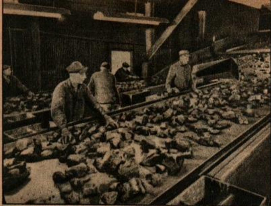
Ci-dessus, des ouvriers retirent les blocs contenant des impuretés avant que le charbon n'arrive aux concasseurs qui le réduiront en morceaux de 7 cm. En bas, un tapis roulant amène le charbon concassé jusqu'aux trémies où il sera mélangé pour acquérir une uniformité chimique le rendant propre à l'utilisation industrielle.
