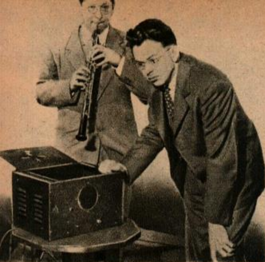
Lorsque l'Orchestre philharmonique de Columbus eut besoin d'un diapason plus précis que le hautbois, les chercheurs ont inventé le „ obotron „ diapason entretenu électriquement.
