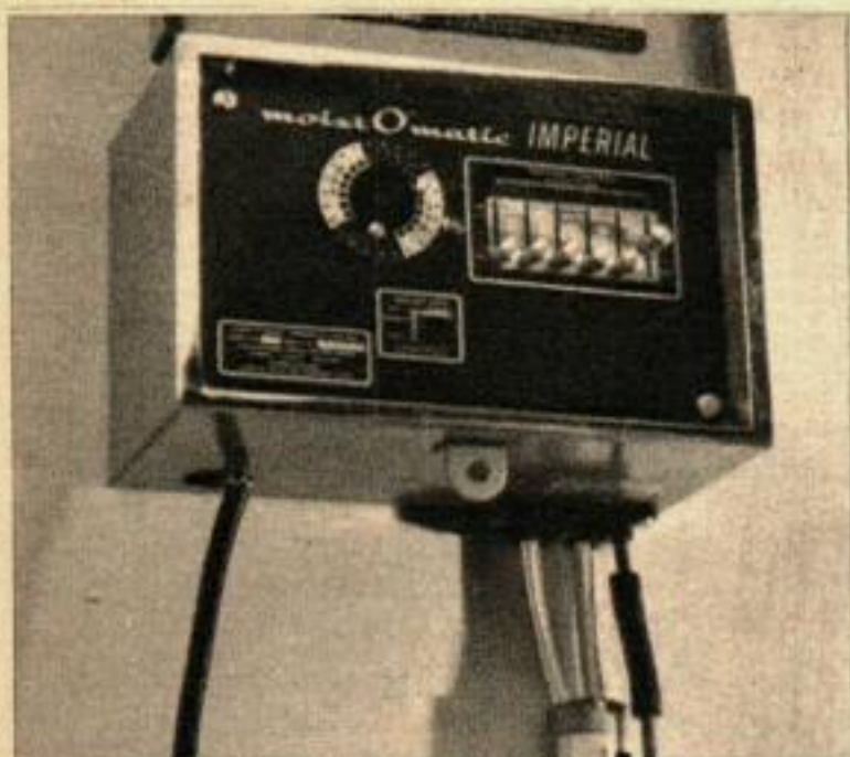
L'élément de contrôle hydraulique peut être fixé sur un mur intérieur ou extérieur. Un tube métallique protège la tuyauterie en plastique.
