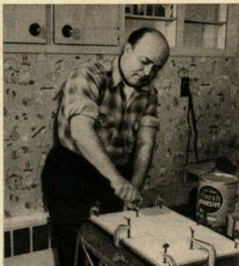
Collage de la couverture de la porte sur contreplaqué de même que sur tous les côtés. Cela forme une bordure de 10 mm qui dépasse de l'ouverture comme montré ci-dessous. Un biseau de 25° est effectué au bord. Maintenir avec des brides de serrage ou des portes.
