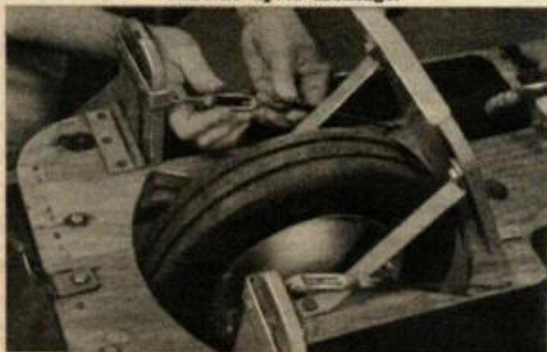
Les tendeurs permettent de régler la tension des câbles de frein et d'accélération. Le réglage est effectué après montage.
