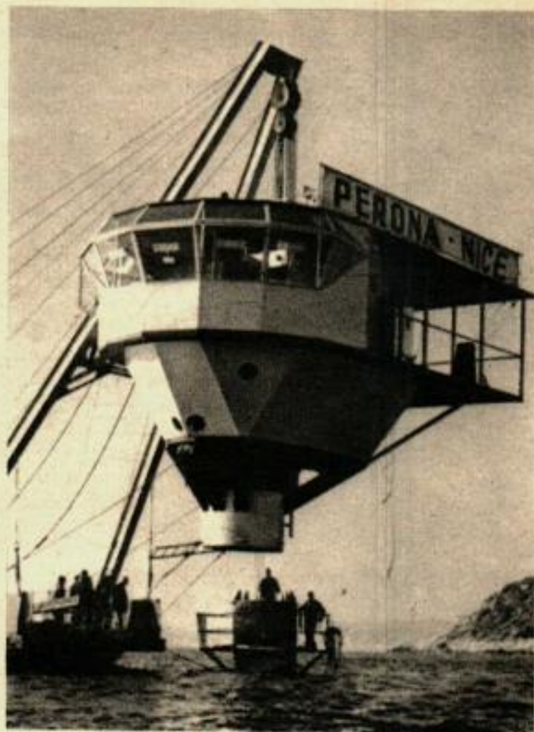
Mise en place à la cime du tube de 54 m, cette « île flottante » abritera les savants qui étudieront la biologie aquatique à partir du tube immergé.
