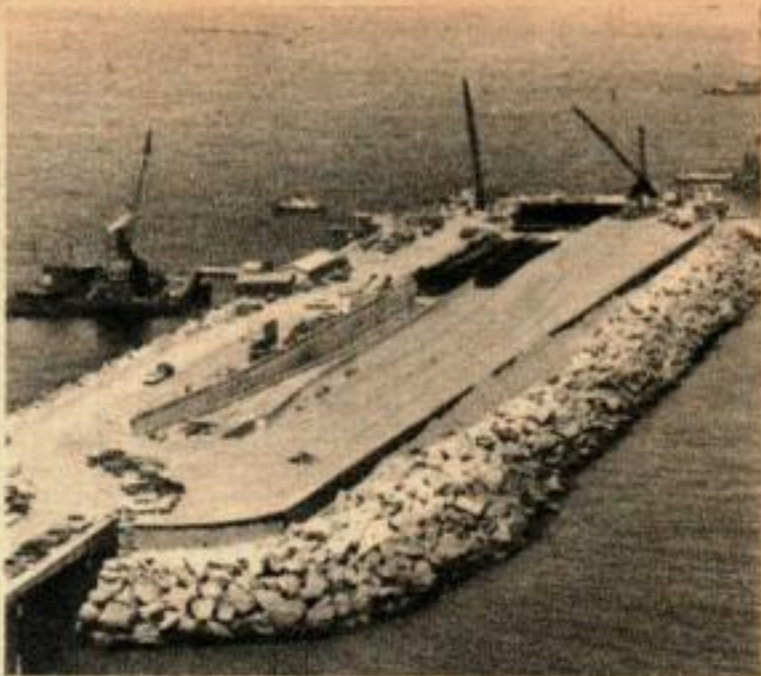
Ces îles sur lesquelles débouchent les tunnels sont créées sur des fonds de 9 à 12 m en formant des piles de sable et de rocaïlle renforcées par des murs en béton sur une surface de 8 ha. L'entrée du tunnel est au milieu de chaque île.
