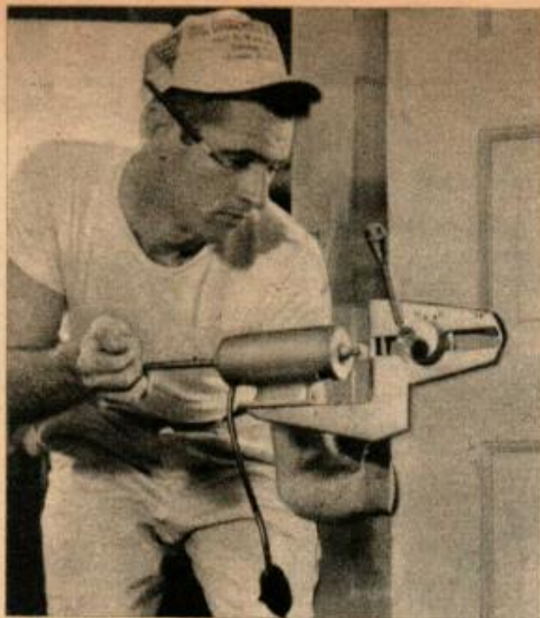
Cet ensemble d'outil mécanique et de gabarit à percer permet d'installer rapidement des serrures cylindriques sur les portes des appartements de série.
