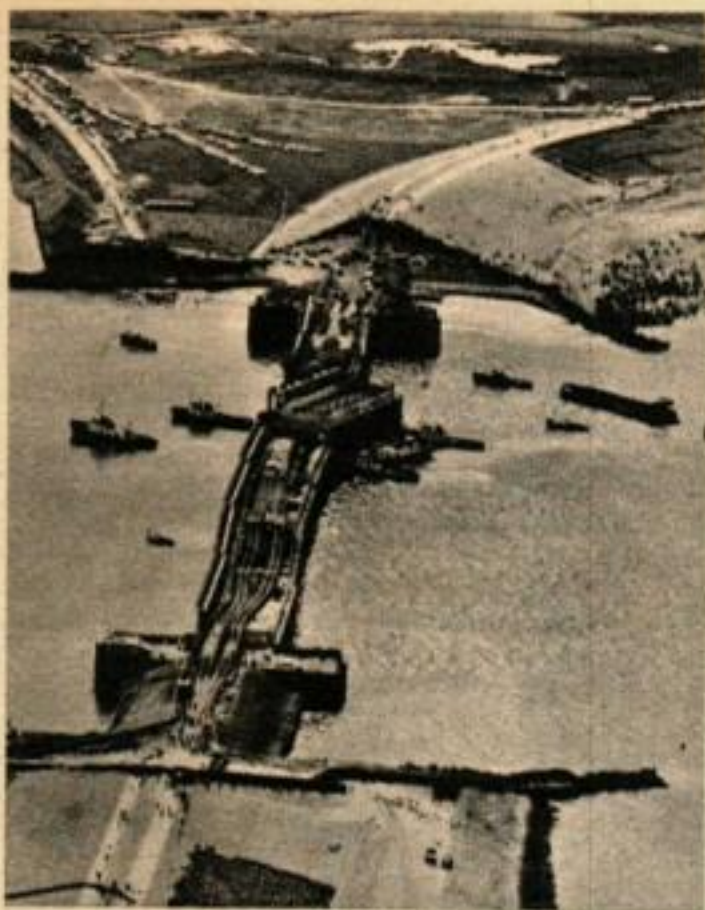
2. — Cette photo aérienne montre la dernière scène du bâclage du « Veersche Gat ». Cinq remorqueurs tirent le dernier caisson vers son emplacement. (Photo T. Slagboom.)
