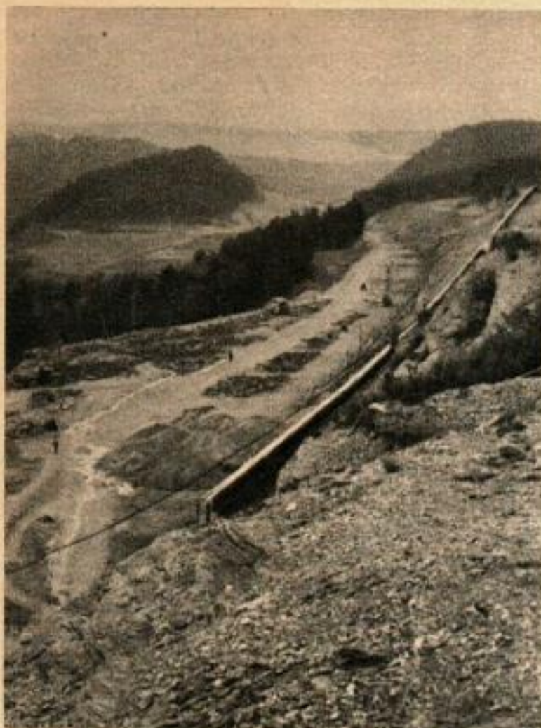
1) La construction de la route d'accès au pont européen sur le versant Est de la vallée du Sill. Vue sur le Nord. La pente au premier plan doit être arrêtée au moyen de murs d'appui.
