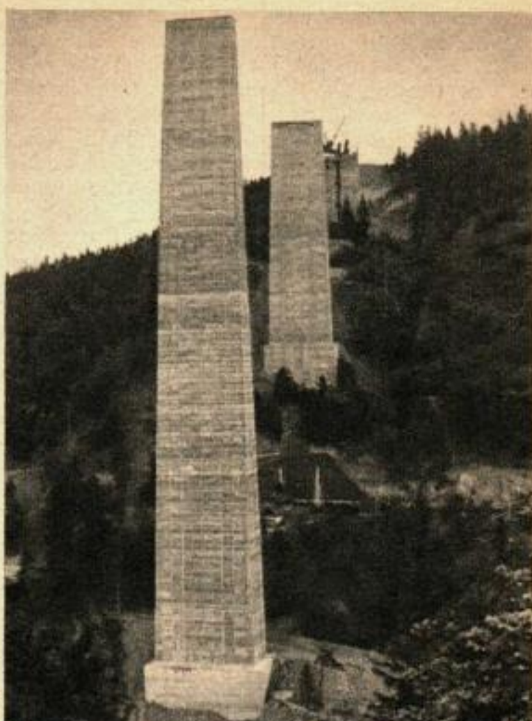
2) Vue sur les piliers II et I depuis l'ancienne route du Brenner. Nous vous signalons que les vitesses de vent de 135 km/h ont déjà été enregistrées par temps de Foehn au sommet du pilier II, à une hauteur de 182 m.
