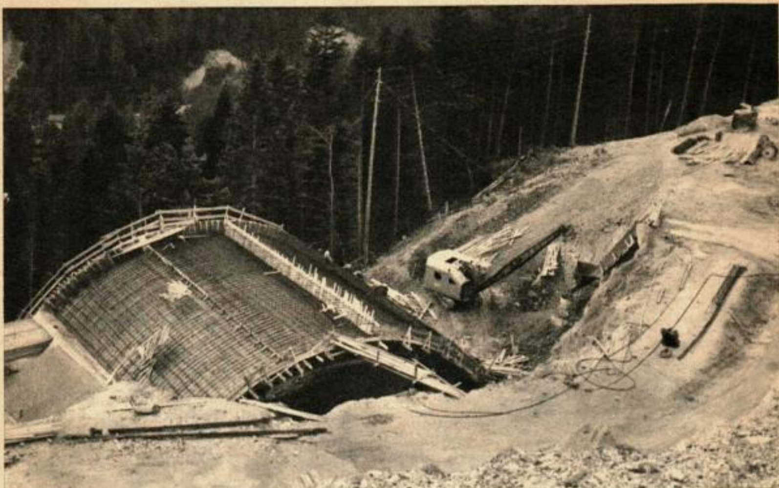
6) Afin de permettre la construction rectiligne de l'autoroute à travers la vallée du Sill, il est nécessaire d'ériger de nombreuses constructions d'art supplémentaires, comme ici sur une pente très forte où la largeur de la route serait normalement diminuée de moitié.
