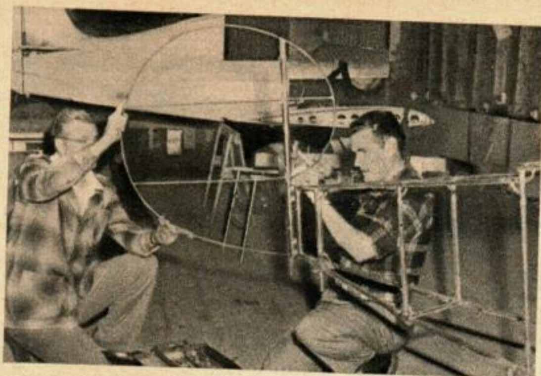
Un Fokker en pleine taille est actuellement en cours de construction par le groupe des amateurs d'antiquités. Comme sur l'original, la cellule est faite de tube d'acier soudé. Un autre modèle expérimental est visible à l'arrière-plan de l'atelier de Bowers.
