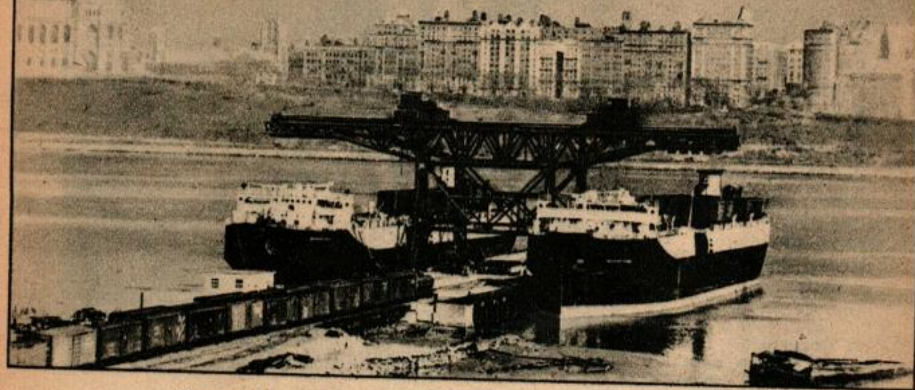
Une double grue de 125 tonnes charge des wagons entiers à bord des bateaux.
