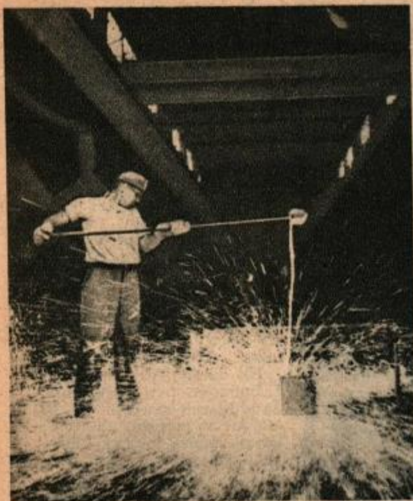
Coulage de l'acier dans une fonderie où sont étudiées les nouvelles techniques pour le maniement des métaux; on y étudie également les derniers alliages et les nouveaux sables à mouler. À droite, le laboratoire d'essai des postes de radio.
