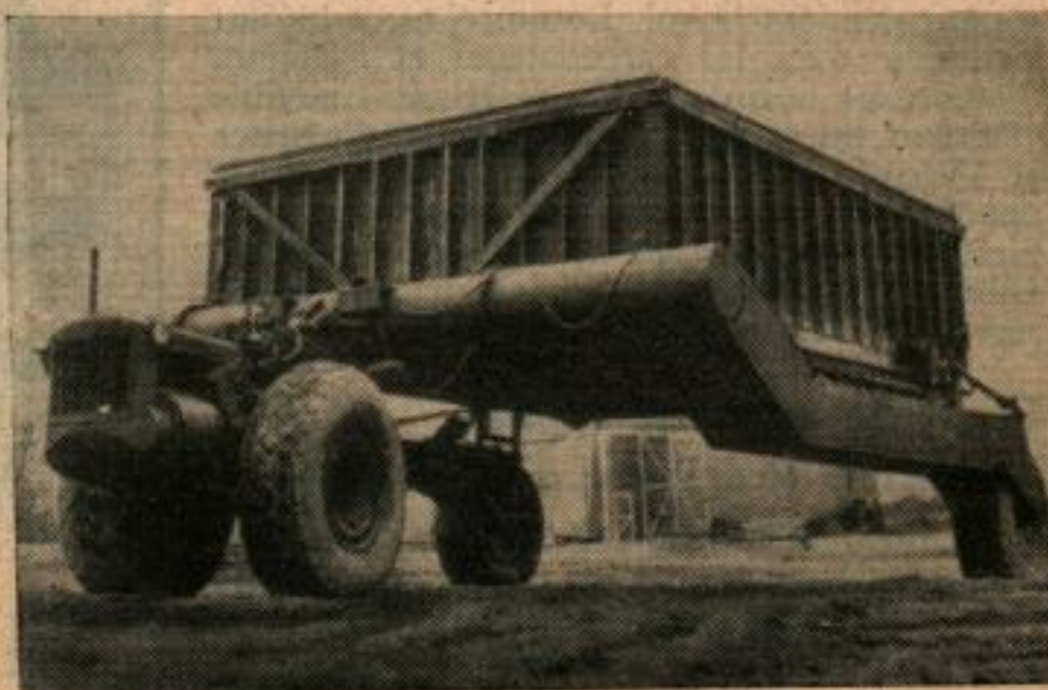
Ci-dessus, la maison a été déposée, et la machine se prépare à reprendre une charge de béton pour une nouvelle maison. Ci-dessous l'appareil en route, contenant une maison.
