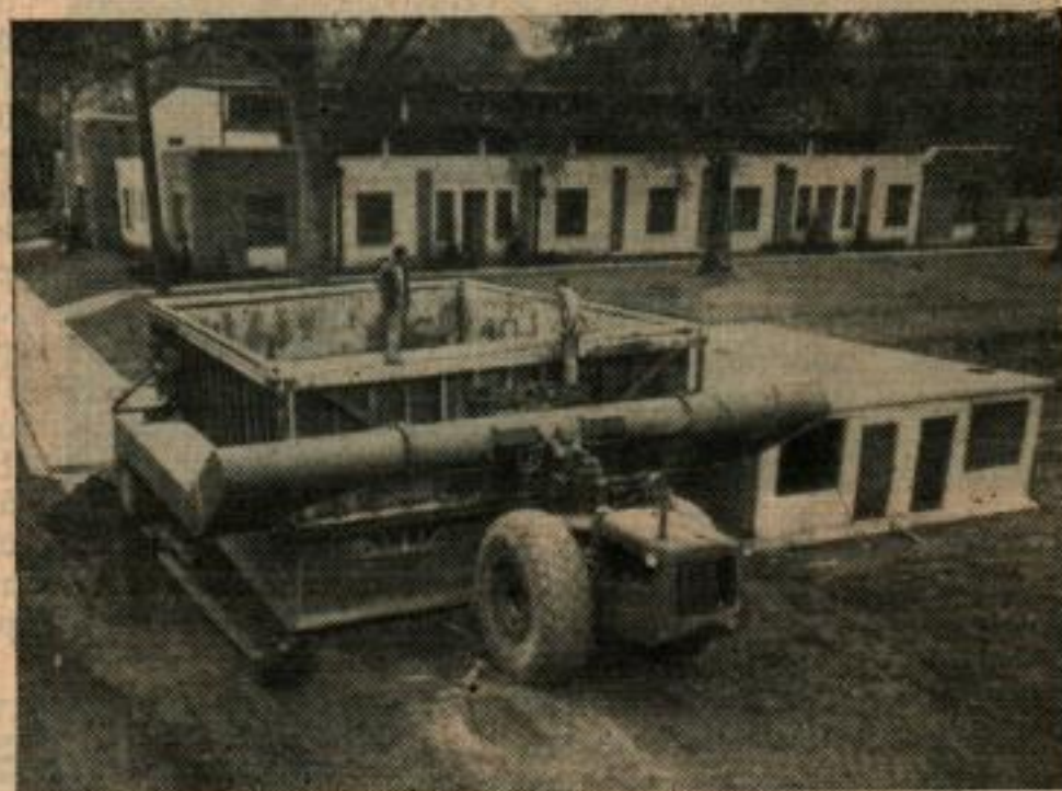
Ci-dessus, la maison a été déposée, et la machine se prépare à reprendre une charge de béton pour une nouvelle maison. Ci-dessous l'appareil en route, contenant une maison.
