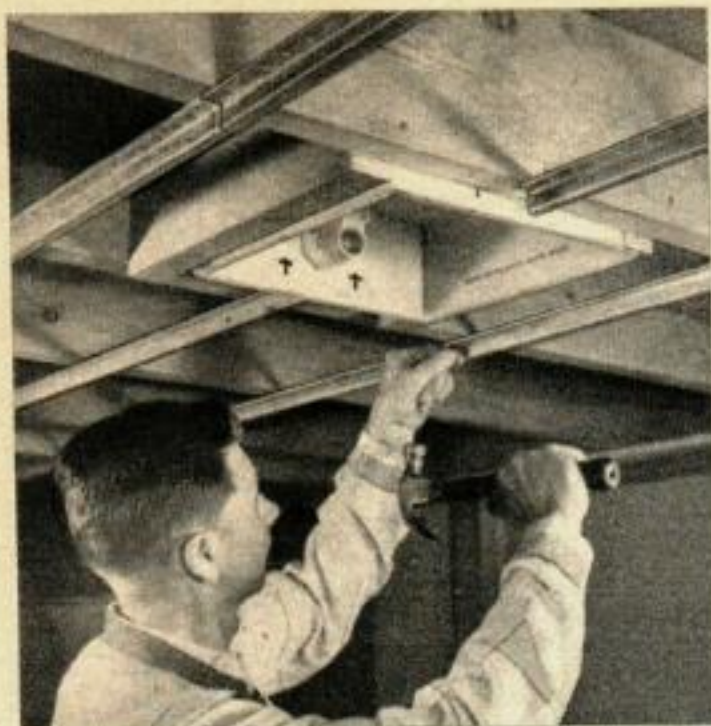
L'installation des baguettes de fourrure métalliques ultra-légères est plus facile que le clouage de planches de fourrure ordinaires.
