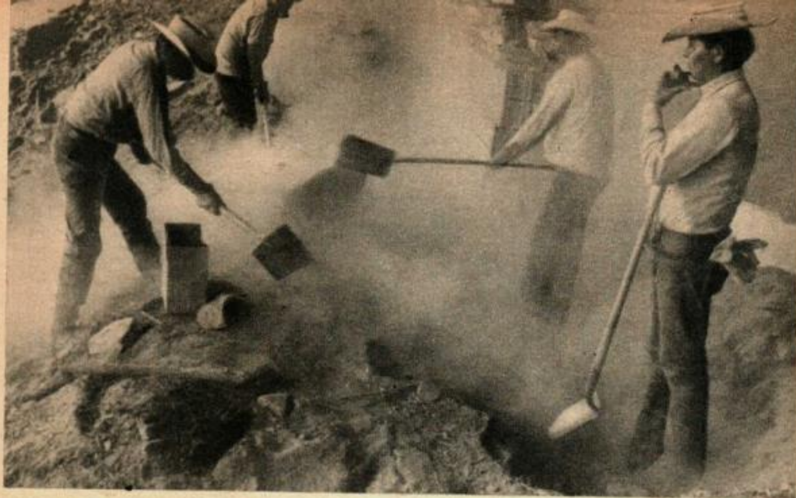
Un danger supplémentaire était celui des émanations de la poussière et des restes fétides d'ordures vieilles de plusieurs siècles mises à jour par les excavations. Les ouvriers portaient des masques respiratoires pour éviter l'infection tandis qu'ils creusaient des tranchées pour la pose des nouvelles fondations.
