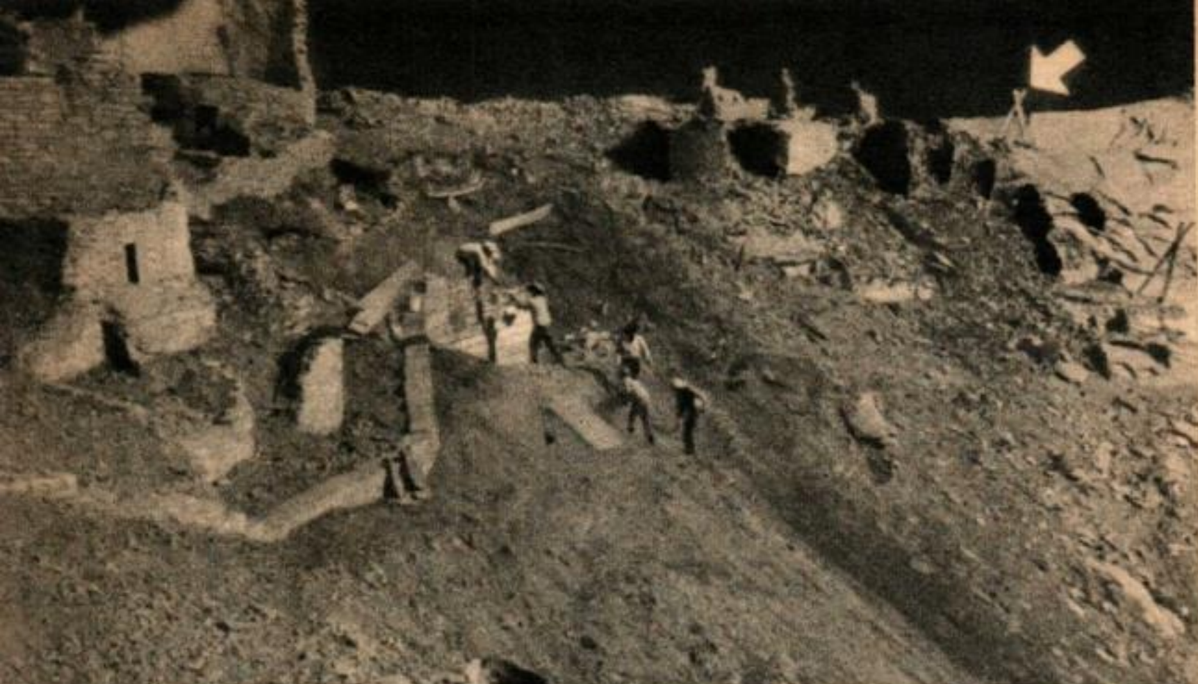
Les conditions de travail étaient dangereuses parce que la caverne est située en haut d'une pente, au-dessus du lit du canyon. Le mortier était hissé depuis le fond avec des câbles tendus sur des supports en ciseau (flèche). Les Navajos sont en train de réparer les murs de soutènement.
