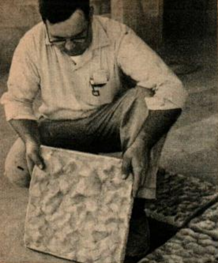
Les pièces coulées confectionnées de cette façon peuvent être utilisées comme des dalles ou, avec un peu d'ingéniosité, comme motifs d'incrustation dans un mur de retenue en blocs de béton ou en autre maçonnerie.
