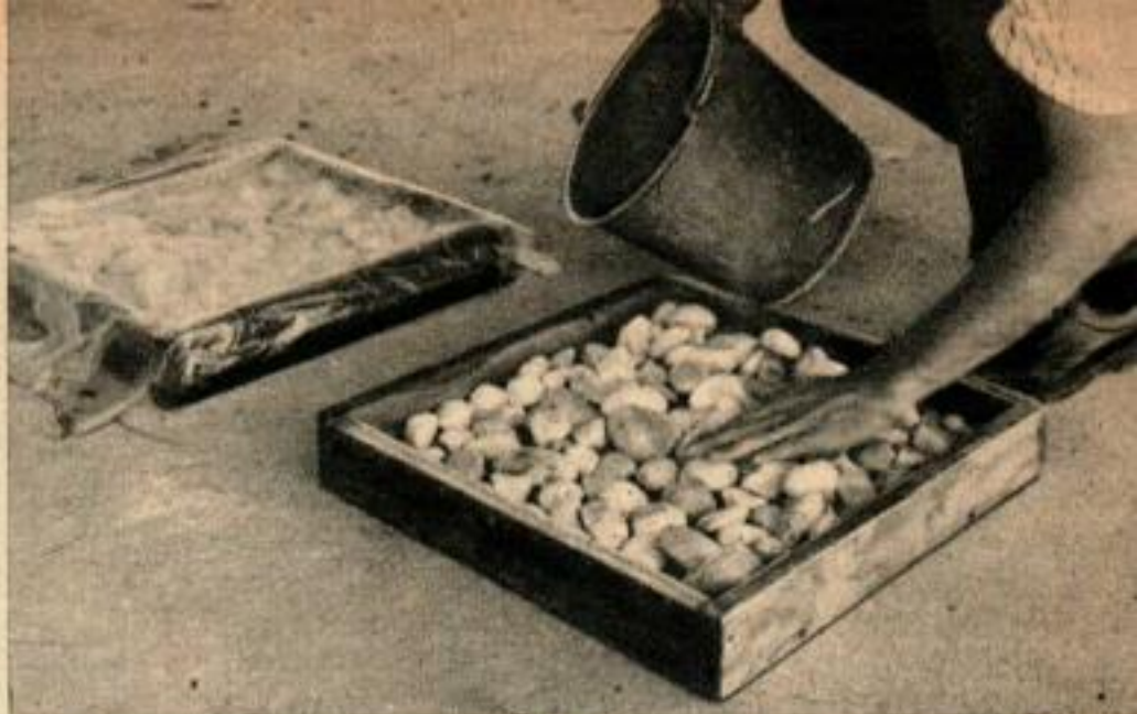
Les pièces coulées confectionnées de cette façon peuvent être utilisées comme des dalles ou, avec un peu d'ingéniosité, comme motifs d'incrustation dans un mur de retenue en blocs de béton ou en autre maçonnerie.
