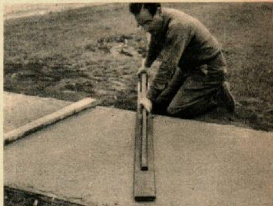
Enfoncer les pierres dans le béton jusqu'à ce qu'elles soient recouvertes d'une mince couche de ciment pâteux. Puis appliquer le produit de retardement de prise.
