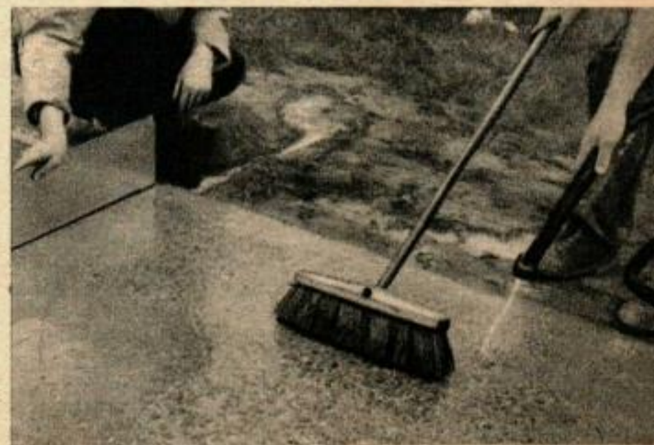
Balayer la surface légèrement et laver l'excédent de pâte de ciment avec un léger jet d'eau, ce qui mettra les pierres à découvert.
